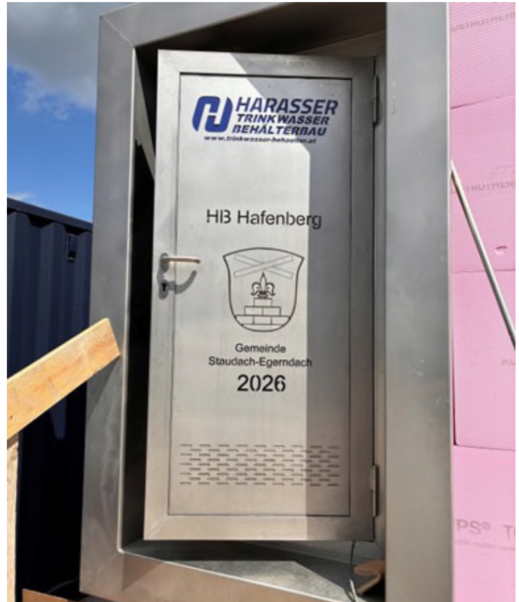
Bild: Eingang zur neuen Anlage am Hafenberg
