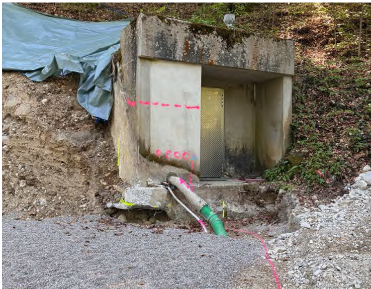
Bild: Standort für neue Anlage am Hafenberg
