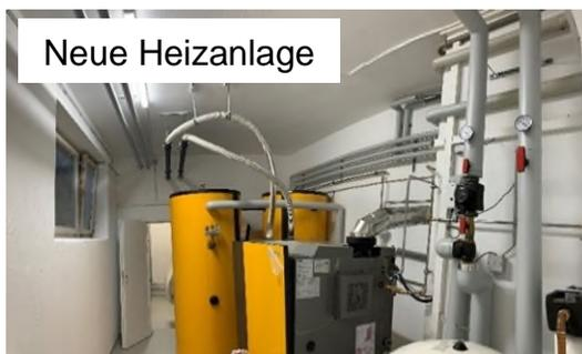
Die Grundschule Staudach-Egerndach wurde 1965 gebaut. 2023 wurde die alte Ölheizung durch einen effizienten Pellets-Kessel ersetzt und 2024 die Heizungsoptimierung fortgeführt. Die Heizungsinstallation und die Heizkörper im gesamten Schulhaus wurden erneuert sowie die Umbaumaßnahmen im Heizraum abgeschlossen. Der Gemeinderat war bestrebt, den Schulbetrieb dabei möglichst wenig zu beeinträchtigen. Daher war das Zeitfenster für die Arbeiten sehr eng, auf die Sommerferien,
